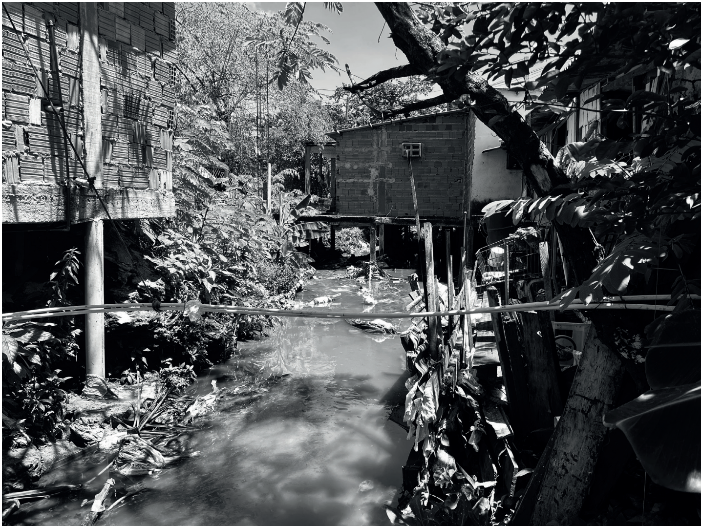
Construções de casas sobre o igarapé o que tem causado mais erosão e expansão do leito
