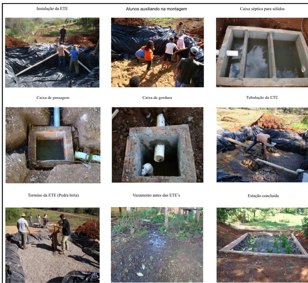
Quadro de fotos 1 – Montagem da Estação de tratamento de esgotos por zona de raízes. Detalhe para o vazamento da fossa negra existente antes do sistema ser instalado.
