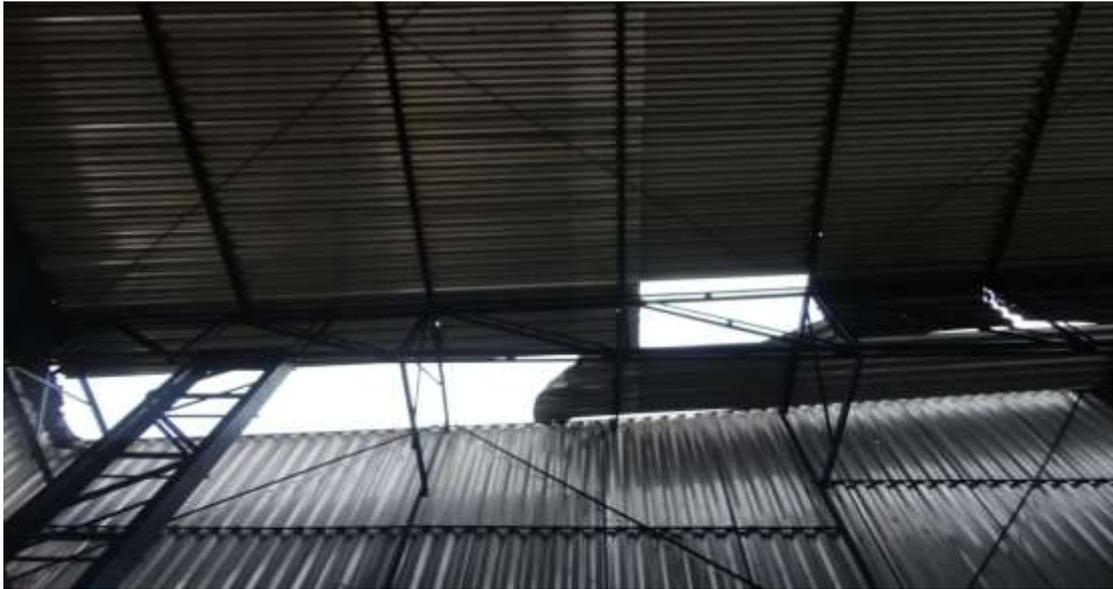
**Figura 4:** A Cobertura Deteriorada provoca alagamento na quadra em dias de chuva, representando risco aos alunos.
