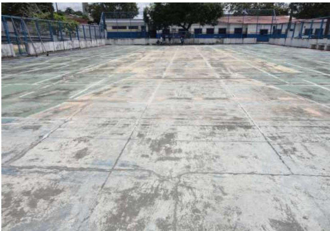
**Figura 9:** Quadra com marcações apagadas e piso com rachaduras.
