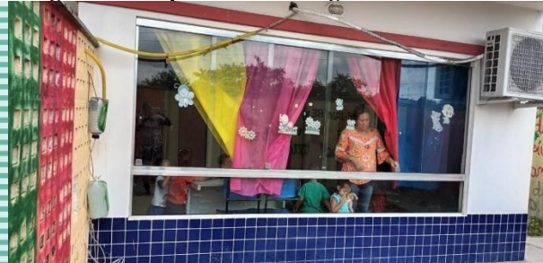
Figura 8: Reaproveitando a água do ar condicionado
